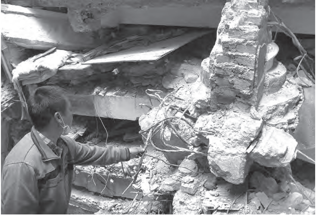
१६ एमएमको डण्डी राखेर ९x९ इञ्चको पिलरमा बनेको गोड्ढुको ९ तले घरको भग्नावशेष देखाउँदै टोखा नगरपालिकाका प्राविधिक रत्नकुमार राई ।
